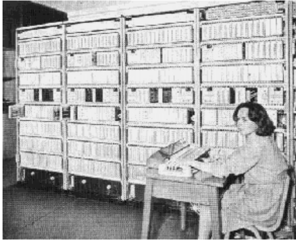
Автоматична телефонна централа М 400 с микропроцесорно управление
